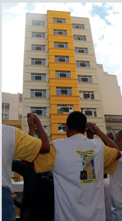
Edifício Nazaré - Projeto Vida Nova
