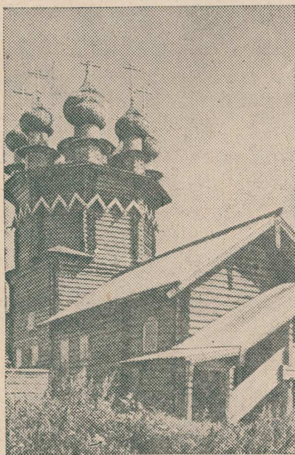
Igreja da Intercessão da Mãe de Deus, na ilha de Kigi. Construída em 1764, inteiramente de madeira, sem nenhum prego.
