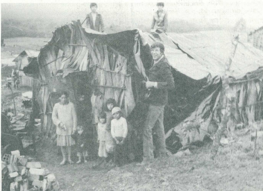
Pe. Laurindo ajudando na reconstrução provisória dos barracos destruídos pela ventania e chuvas constantes em Clevelândia.
