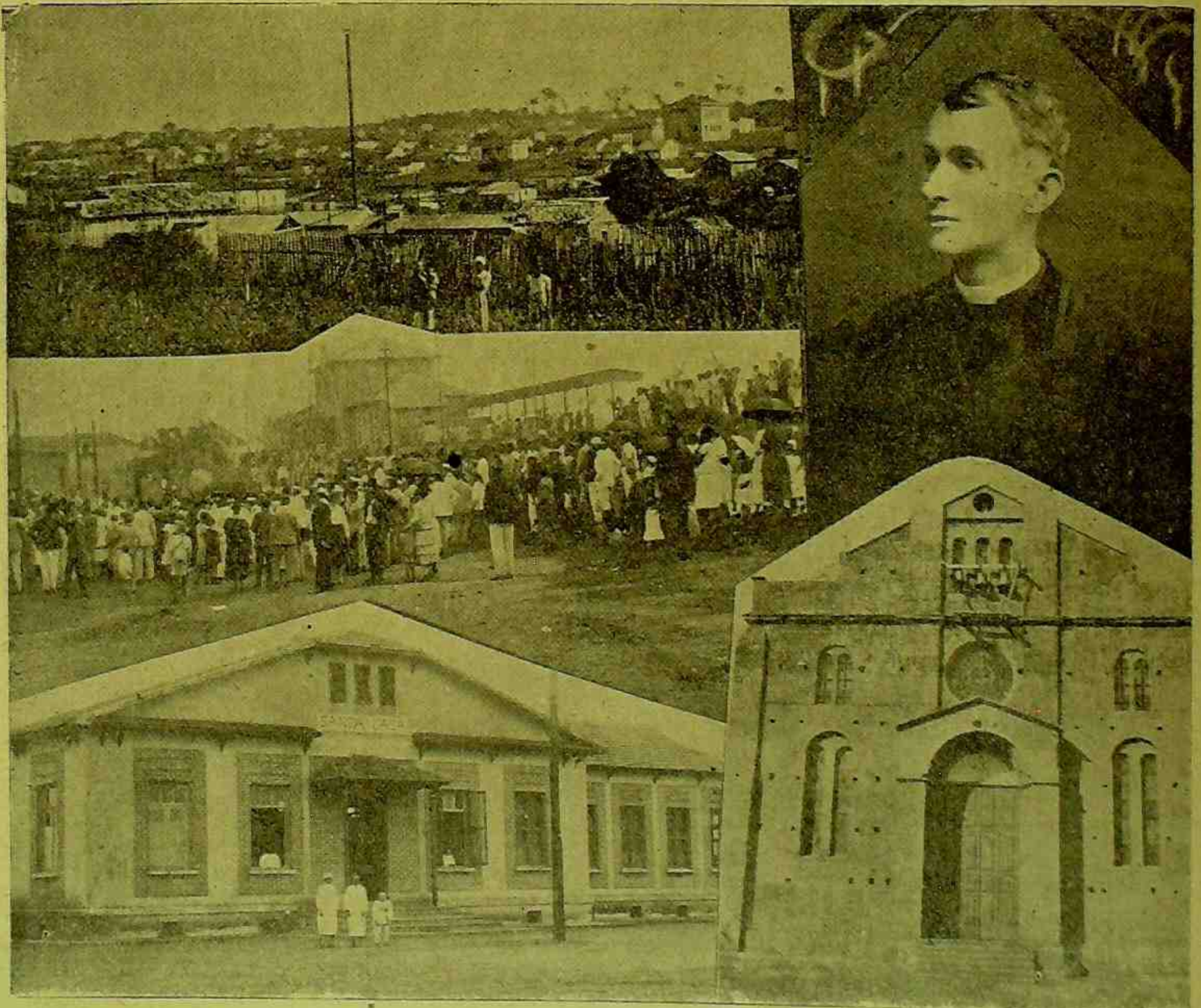
ASSIS — Vista geral da cidade; Rvmo. P. David, zelosissimo Vigario; Santa Casa; Estação: chegada do sr. Bispo; Igreja nova que o povo de Assis construiu em menos de dois annos.
