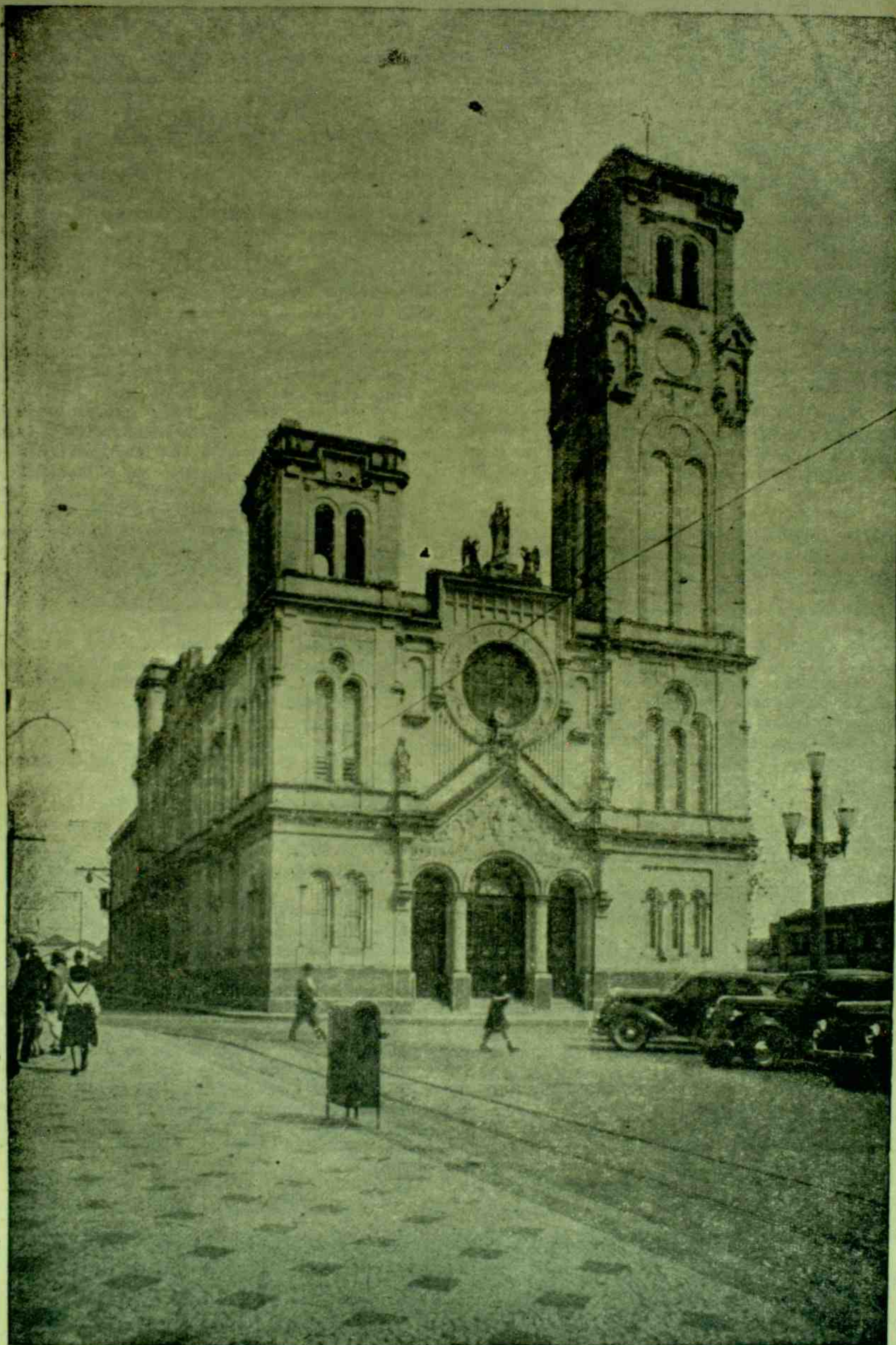
CAMPINAS — Igreja do Rosário, construída e decorada com os esforços dos Missionários do Coração de Maria e com a generosidade do povo campineiro. Sobre esse monumento lançou-se a sentença do derrubamento, para seguir os traçados do urbanismo!
