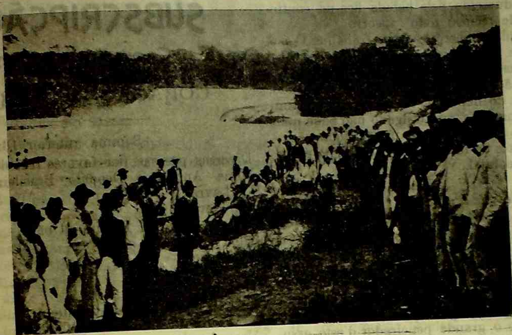
Inauguração dos trabalhos do canal e da usina da Empresa Electrica de Nuporanga. Depois do pic-nic numa ilhota da cachoeira o presidente da empresa Coronel Joaquim Ferreira da Rosa rodeado pelos convidados e Engenheiros da empresa. Na Casa da cachoeira junto a uma canoa tripulada pelo Tte. Elias de P. Machado e outros, o Sr. Simpliciano da Rocha. Pombo arrojado nadador que chegou a nado na occasião. No fundo a enorme catadupa que se despenha em altura de 9 metros.
