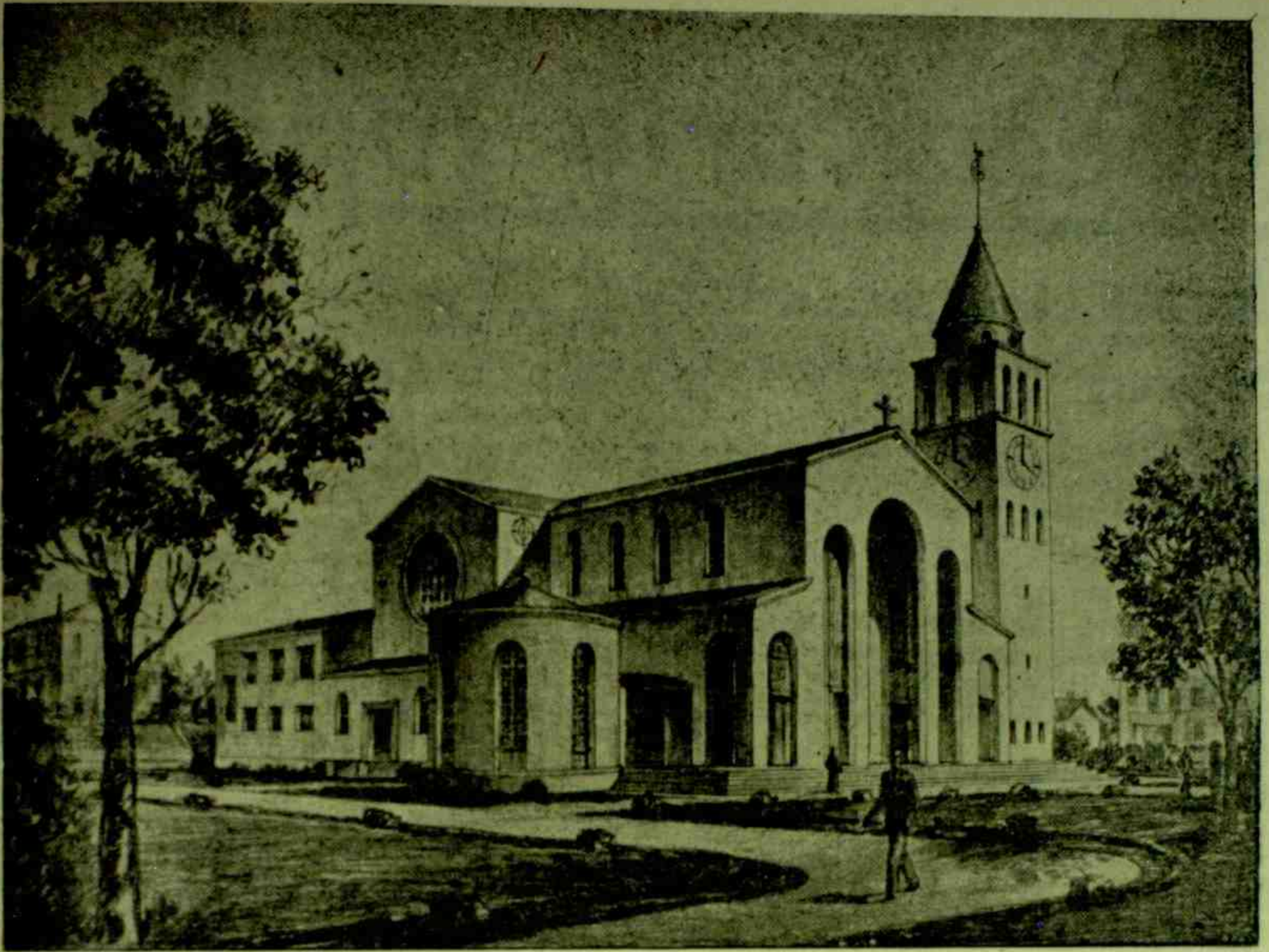
LAMBARÍ — Projeto do artístico templo de Nossa Senhora da Saúde, que está sendo construído pelo P. José Ramos Leal, Vigário da Paróquia.
