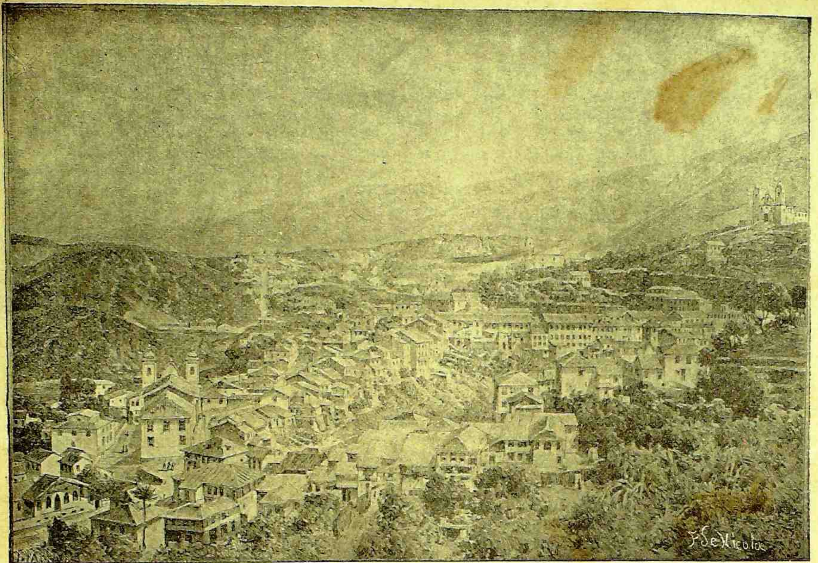
Cidade de OURO PRETO.—Vista geral.
