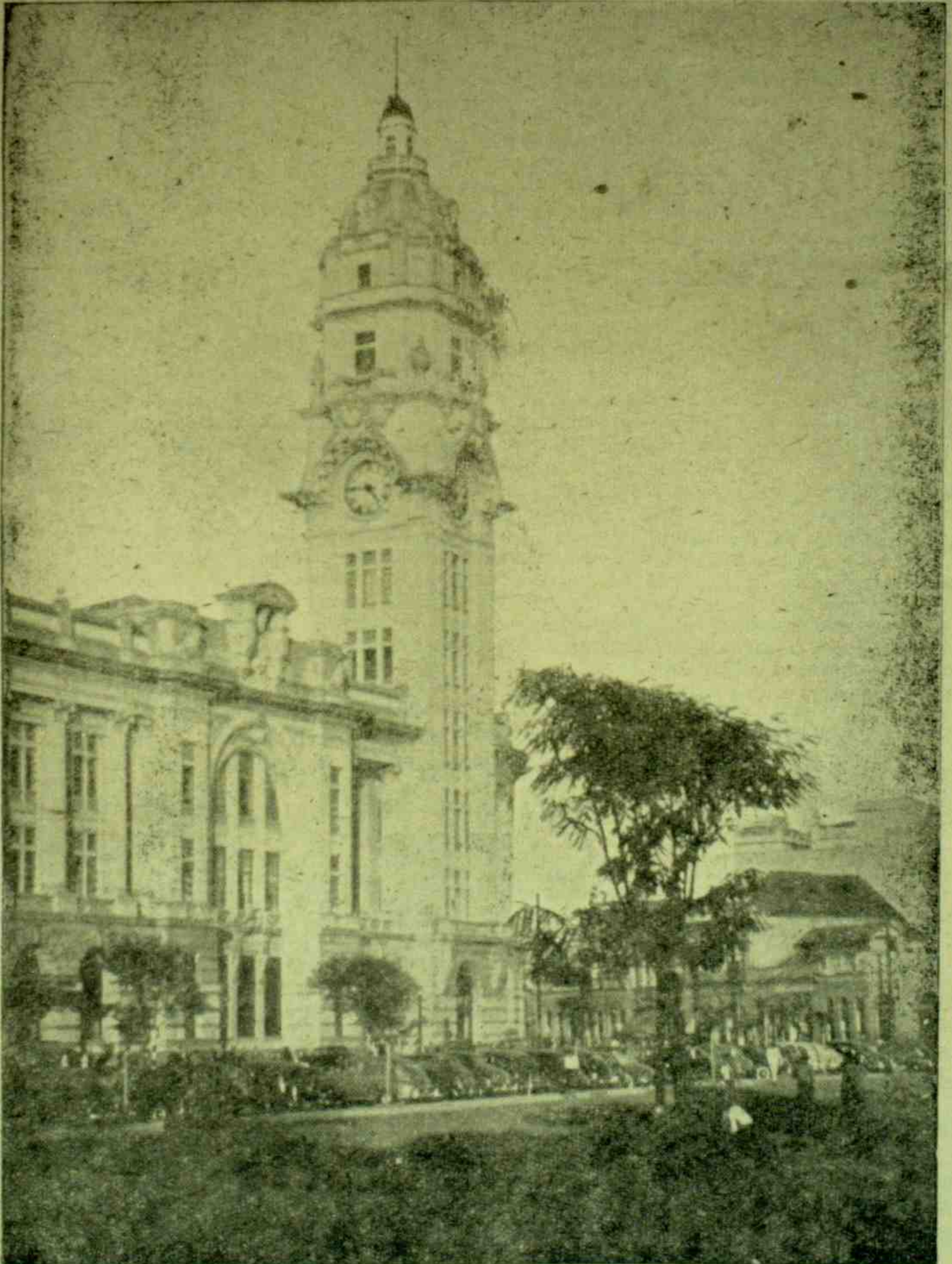
Majestosa torre e parte do prédio imponente da Sorocabana, nesta cidade de São Paulo.
