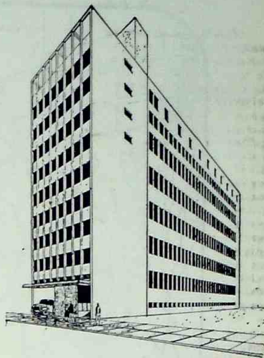
Na foto acima, o novo edifício da Editora "AVE MARIA", já construído e em fase de acabamento. Com o auxílio de novas máquinas "offset", a quatro cores, a revista será ampliada e renovada, possivelmente no decorrer de 1968.
