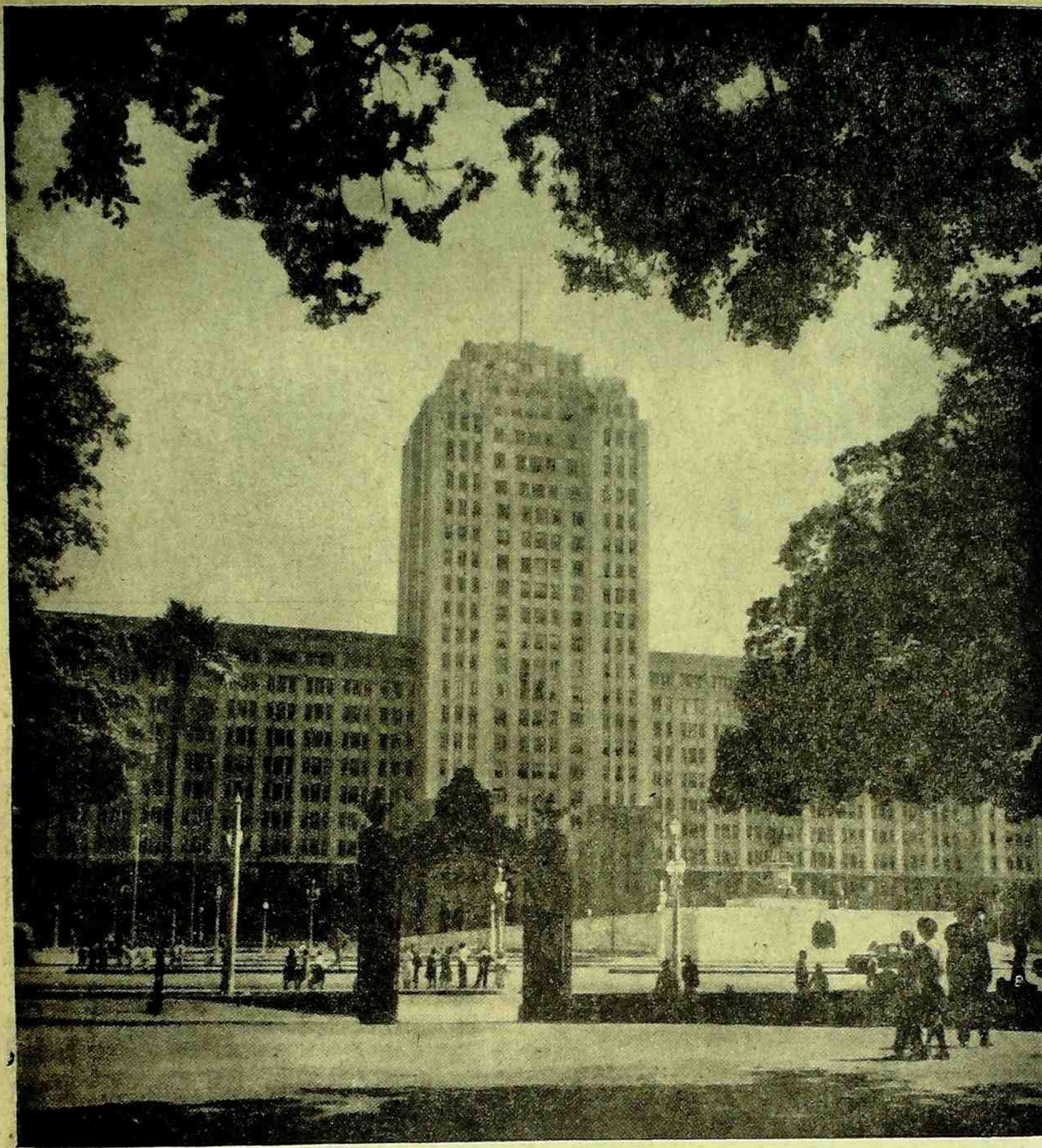
RIO DE JANEIRO — Edifício do Ministério de guerra
